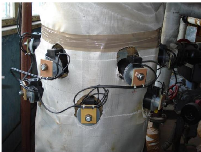
Рис. 2 и 3. Фото установленных УЭП-1 на трубопроводах
