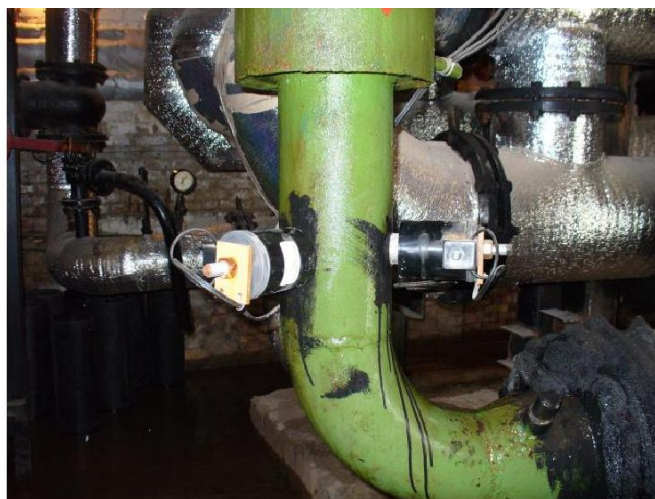
Рис. 2 и 3. Фото установленных УЭП-1 на трубопроводах
